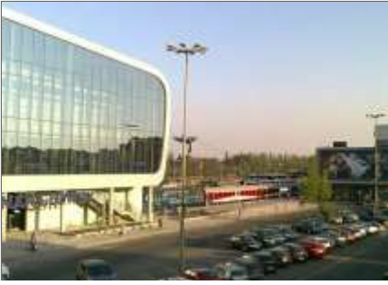
ポズナン中央駅の新駅舎（右）と旧駅舎。 新駅舎の後ろ半分は、実はまだ工事中 （4月30日現在）。
